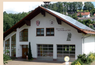
Freiw. Feuerwehr Pfaffenhausen Austraße Tel. 0 60 59 - 93 31
