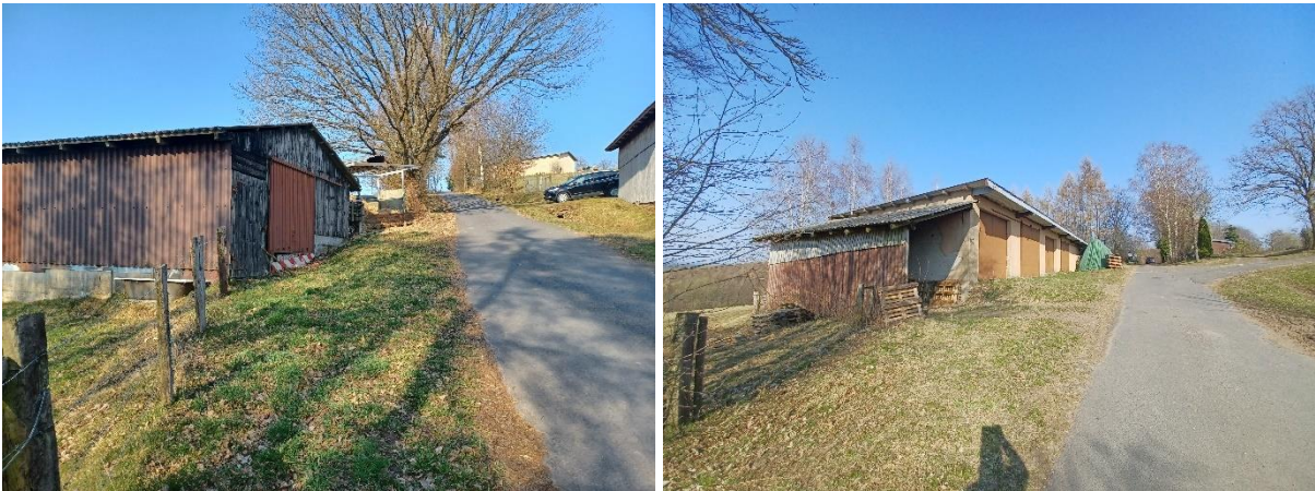
Abb. 10: Scheunengebäude südlich und südwestlich des Plangebiets – Quelle: Eigene Aufnahme
