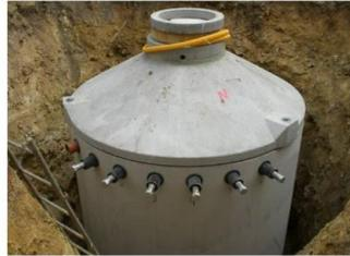
In der Erde versenkter Betonspeicher (Innen Stahlauskleidung)
