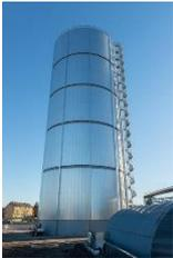
Freistehender Speicher des Nürnberger Wärmenetzes aus Stahl (33.000 m<sup>3</sup>; D = 26 m; H = 70 m)
