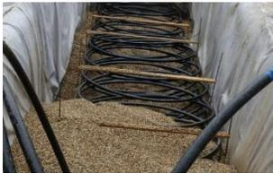
Aufbau eines Kies-Wasser-Wärmespeichers
