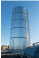
Freistehender Speicher des Nürnberger Wärmenetzes aus Stahl (33.000 m 3 ; D = 26 m; H = 70 m)
