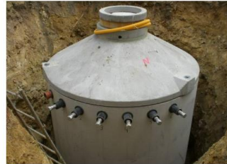
In der Erde versenkter Betonspeicher
