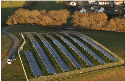
Solarthermische Anlage auf Freifläche
