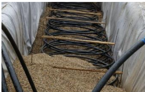
Aufbau eines Kies-Wasser-Wärmespeichers
