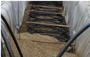
Aufbau eines Kies-Wasser-Wärmespeichers
