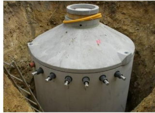
In der Erde versenkter Betonspeicher (Innen Stahlauskleidung)
